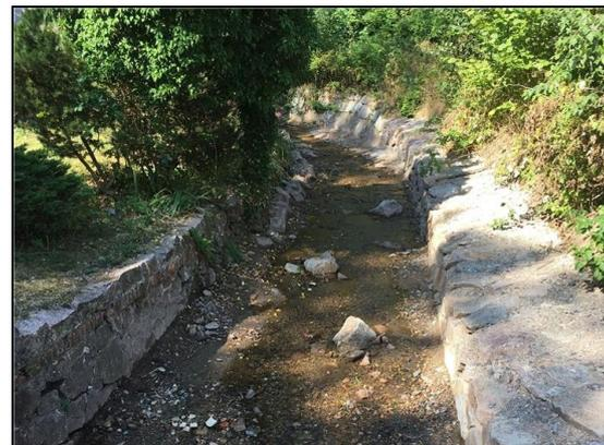
Abb. 6: nach der Maßnahme: Beräumtes Gewässerprofil mit Störsteinen, wiederhergestellte Ufermauern, 01.08.2018
