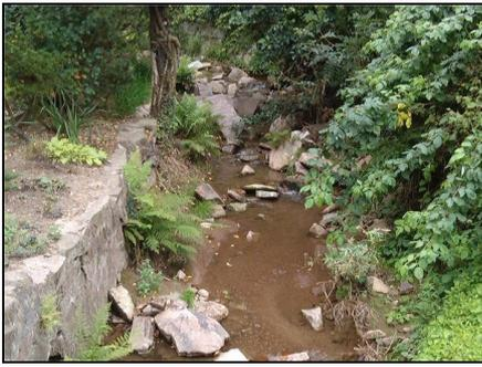
Abb. 2: vor der Maßnahme: Beschädigte Uferbefestigung mit Blöcken im Gewässer, 12.08.2014
