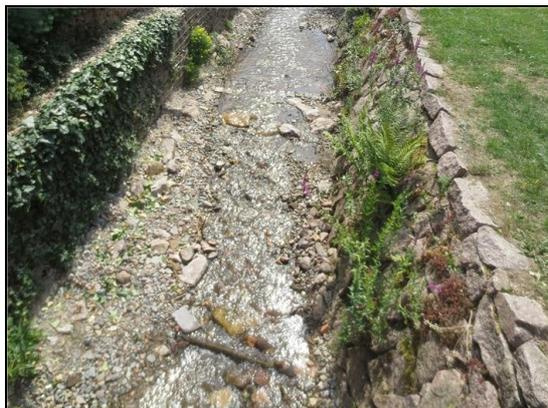
Abb. 5: nach der Maßnahme: Neu befestigtes, strukturiertes Gewässerbett mit gewässertypischem Sohlmaterial, 18.07.2018
