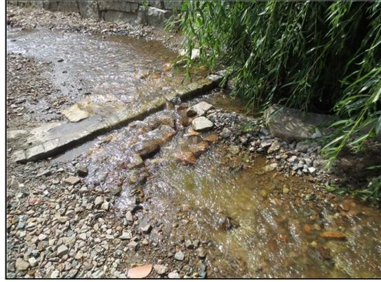
Abb. 8: nach der Maßnahme: Beseitigung des Absturzes und Sicherung durch Bau Sohlrampe, 18.07.2018
