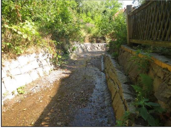
Abb. 7: nach der Maßnahme: Wiederhergestellte Uferbefestigungen, 01.08.2018
