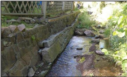
Abb. 3: vor der Maßnahme: Beschädigte Ufermauer, 03.06.2015
